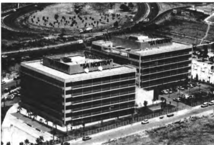
Son Fuster, edificios construidos con los ultimos avances tecnológicos.
