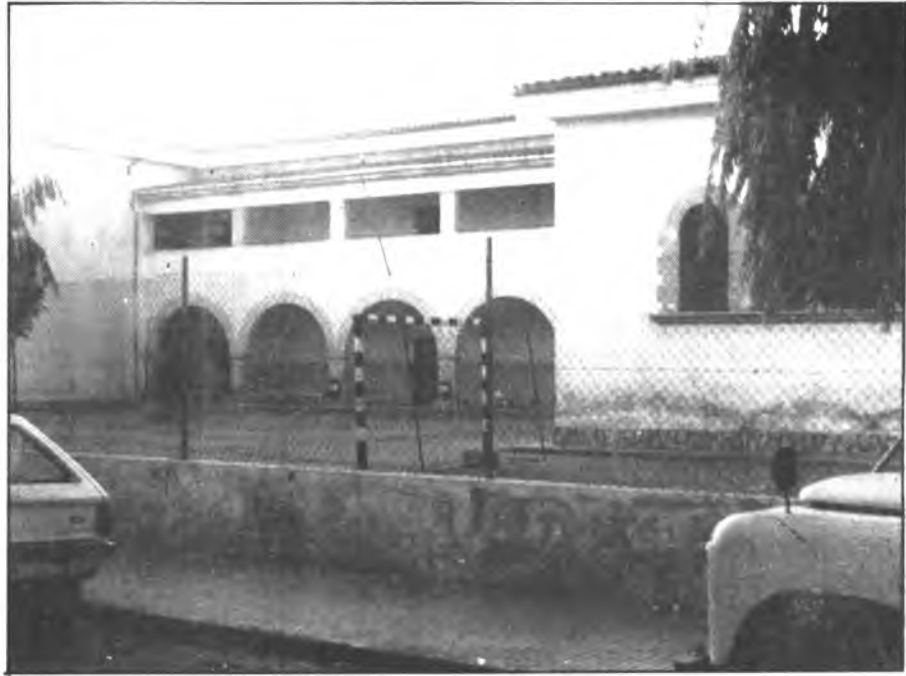
Las obras de nunca acabar
