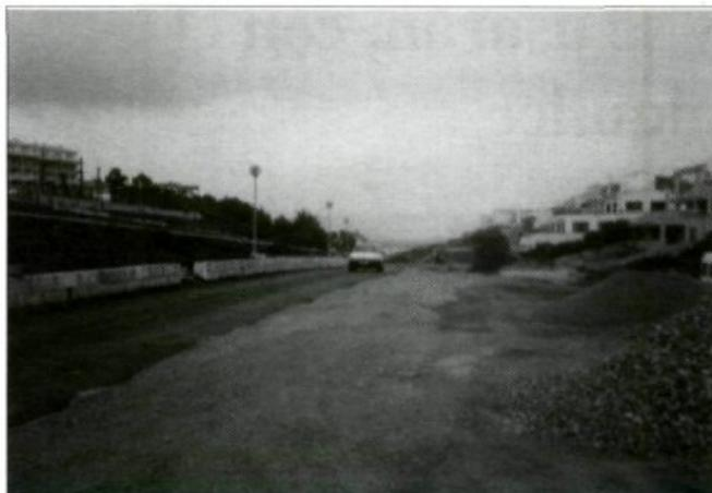
*Vista parcial del nuevo encauzamiento del pequeño torrente de Cala Mandía. Se han encofrado las paredes de ambos lados y tiene tres grandes ojos para salida de aguas.*
