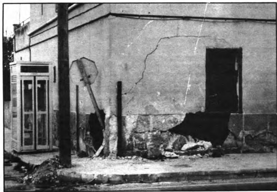
La cantonada d'aquesta casa a la Plaça dels Molins de Vent de Sa Casa Blanca va quedar com mostra la fotografia a causa de l'impacte d'un cotxe. Afortunadament ningú dormia dins el quarto de la cantonada a les dues de la matinada, hora en què se va produir el fet.
