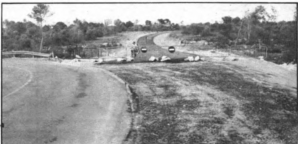
L'Autovia de S'Arenal està acabada a la zona de Cala Blava, a les altres zones s'ha fa molta de feina. Suposam que aquest estiu estarà en funcionament.
